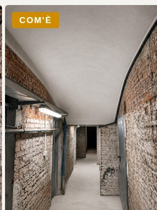
SOFFITTI · GEOMALTA + FIBRA DI BASALTO
