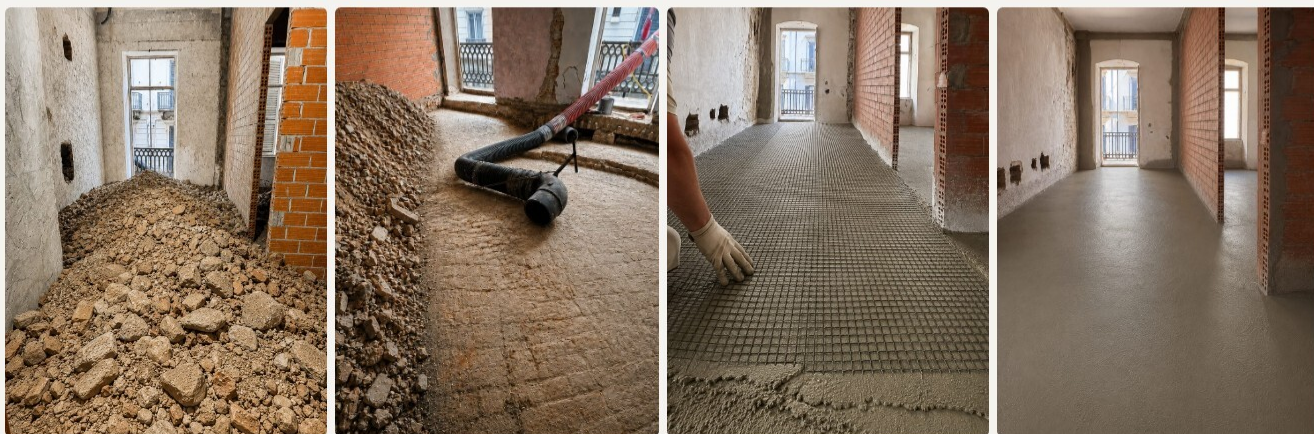
MACERIE → ASPIRAZIONE → RETE DI BASALTO → SOLAIO FINITO
